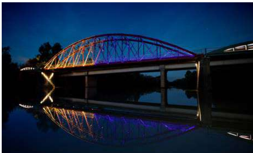
Puente de los Remedios, Villafranca de Córdoba 2022.
