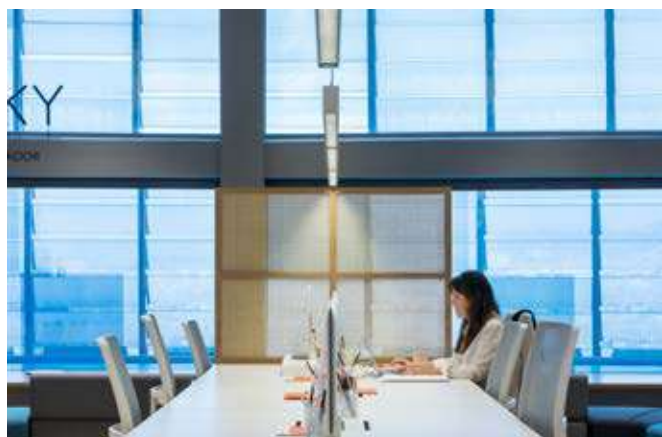
Loom, Barcelona 2020-2022. Control de iluminación D4i. Intensidad 80%. Escena con ocupación. Intensidad 25%. Escena sin ocupación.
