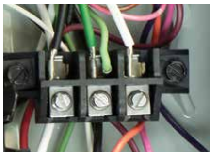
El bloque de terminales se puede cablear usando solo un destornillador de punta plana
